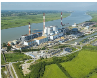
Centrale à charbon à Cordemais (il y en a 4 en France en 2020).
