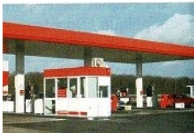
Station service fournissant du carburant à base de pétrole.
