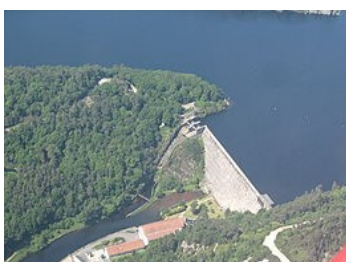
Barrage du lac de Guerlédan (énergie hydraulique)
