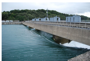
Usine marémotrice de la Rance entre Dinard et Saint Malo
